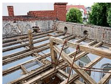
Der erste Schritt ist getan: Das Dach der Turnhalle wurde bereits abgebaut.
