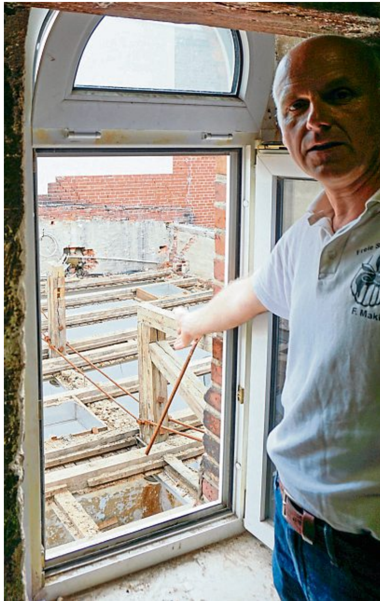
Ferenc Makk erläutert die laufenden Abrissarbeiten.
